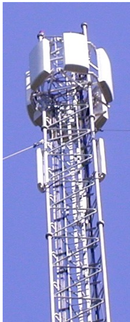
Рис. 10. Тестовая сота GSM-1800 в г. Бьёрнлунда (оператор: Tele2).
